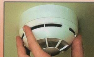
Для раннего обнаружения пожара в квартире и сигнализации о нем установите автономный пожарный извещатель.
